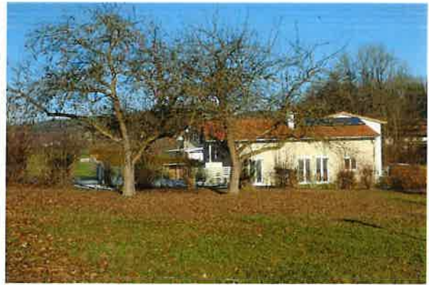
31.12.2020: Blick von der Zufahrt des Feuerwehrgerätehauses zum Anwesen auf Grundstück Flnr. 223/0. Zumindest der linke Apfelbaum wird vermutlich ein Opfer der Bauarbeiten für die Erschließungsstraße.
