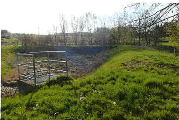
28.04.2021: Blick vom Wintener Graben über das Regenrückhaltebecken in Richtung Kieferlinger Straße
